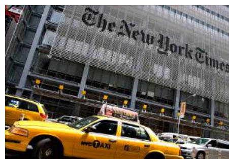
Erdgeschoss des New York Times Tower in New York
